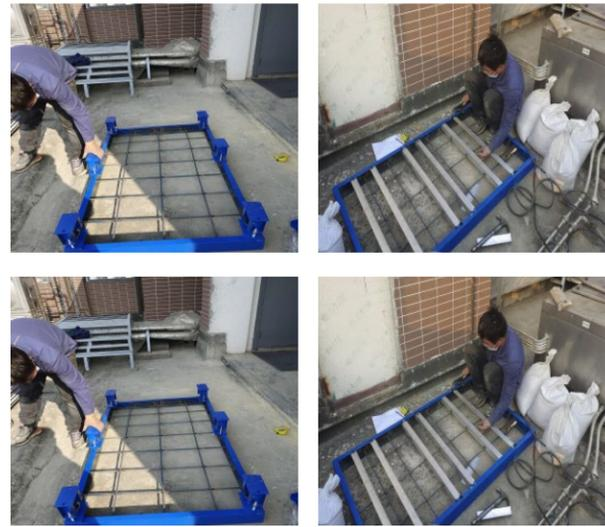
水喷雾系统安装减震基础及防护罩改造过程
